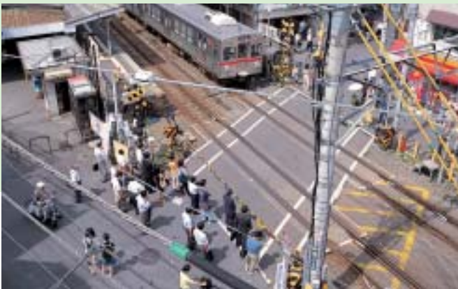
〈立体交差化前の状況〉
